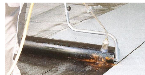
Foto/2/ Variantní natavování rozbalovačem rolí
