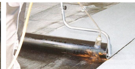
Foto/2/ Variantní natavování rozbalovačem rolí
