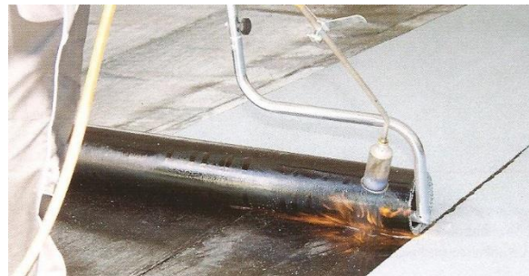
Variantní natavování rozbalovačem rolí
