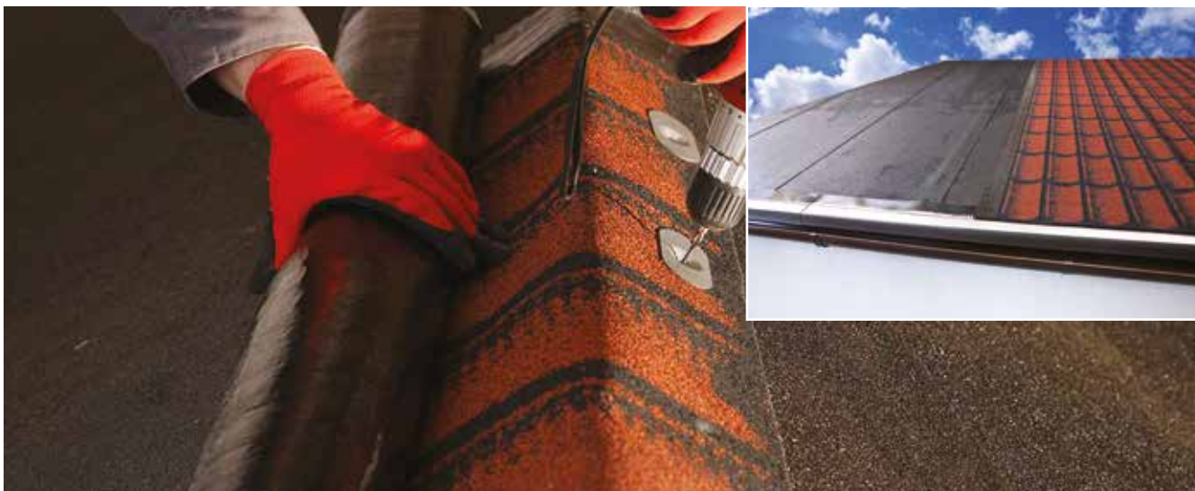
Rozměření a položení pásu RDI 3D na střechu a zahájení montáže od hřebene
