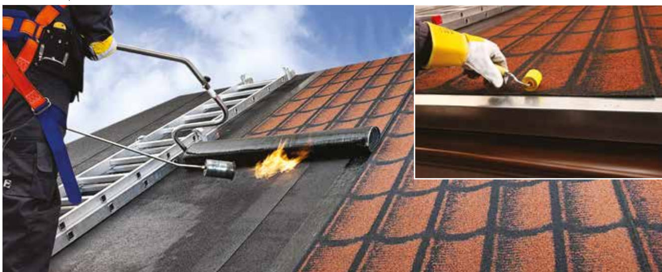
Natavování pásu RDI 3D na šikmou střechu
