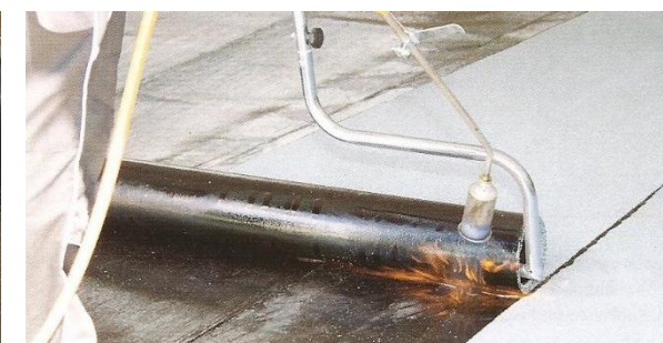
Variantní natavování s rozbalovačem rolí
