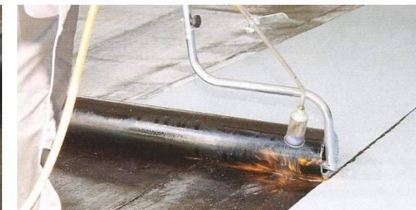
VARIANTNÍ natavování s rozbalovačem rolí
